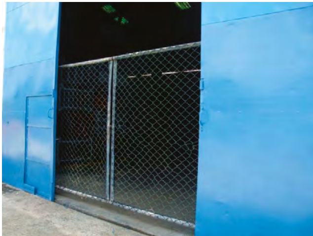
Fig. 2.12. Puerta de malla adosada a la pared del almacén o a su puerta.
