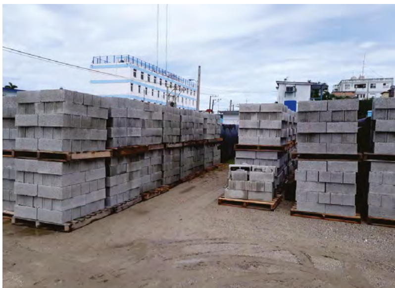
Fig. 3.9. Almacenamiento de bloques unitarizados sobre paletas recibidos así del proveedor.
