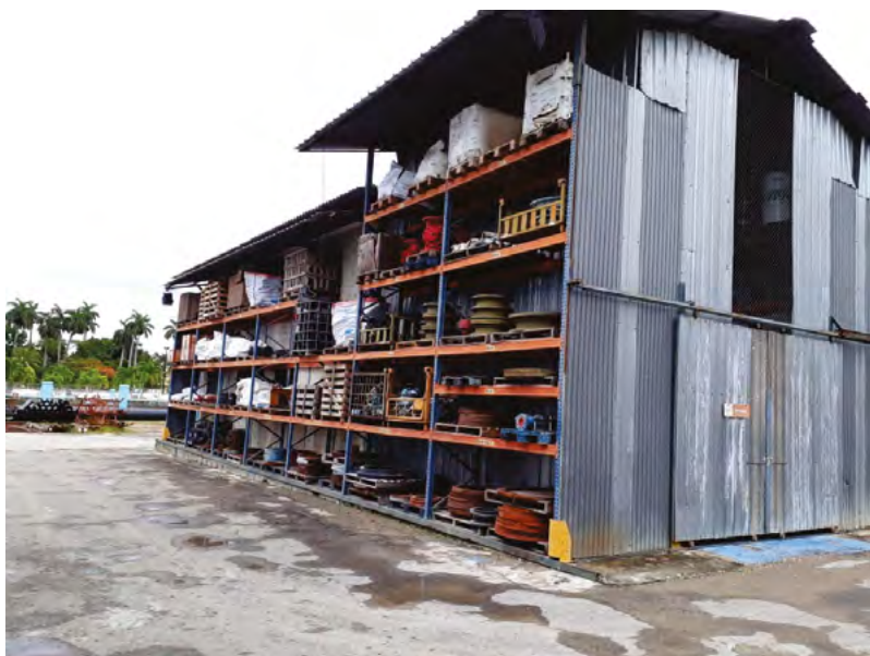
Fig. 3.6. Alero apoyado en estantería para paletas.
