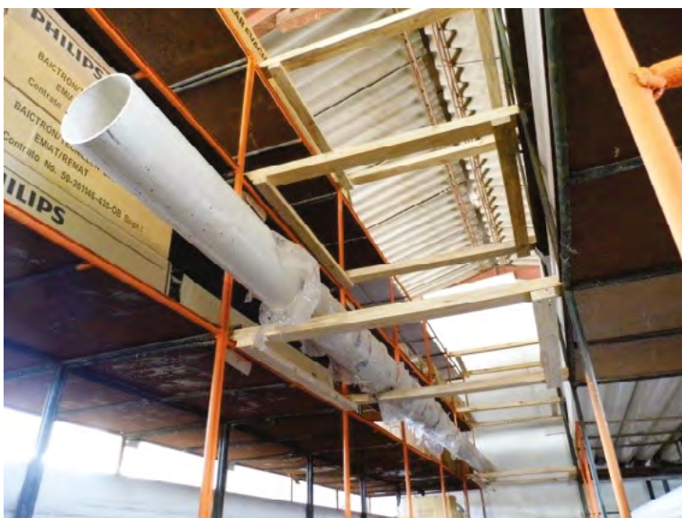
Fig. 2.10. Cunitas tecnológicas de madera para cargas largas en la parte superior del pasillo de trabajo.
