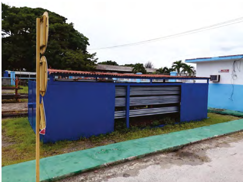
Fig. 3.5. Nave autoportante especializada cerrada para cargas largas.
