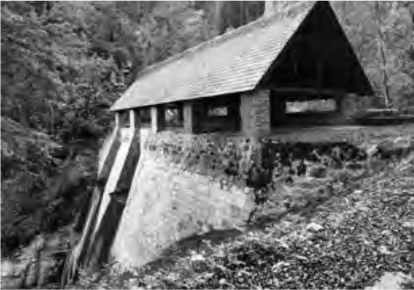
**Imagen 7.** Una de las represas que controlaban el agua para el transporte de madera hacia la mina de Idria, Eslovenia.
